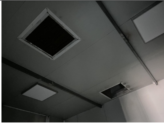
调漆废气收集
