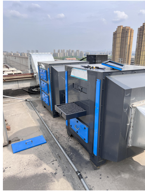
SDG+活性炭复合吸附装置+排气筒 图 3-5 废气处理设施图片
