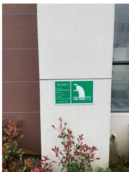
污水排口标识
