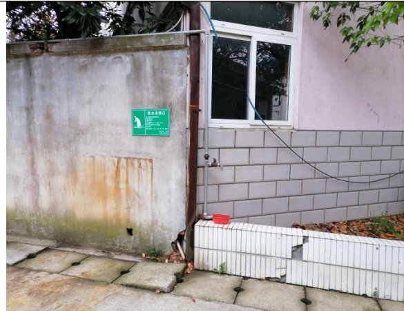
图 3-5 污水总排口标识
