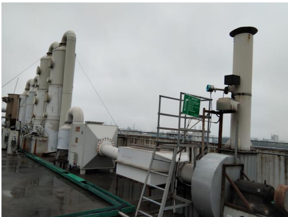
多功能加工一车间: 布袋除尘+喷淋+排气筒
