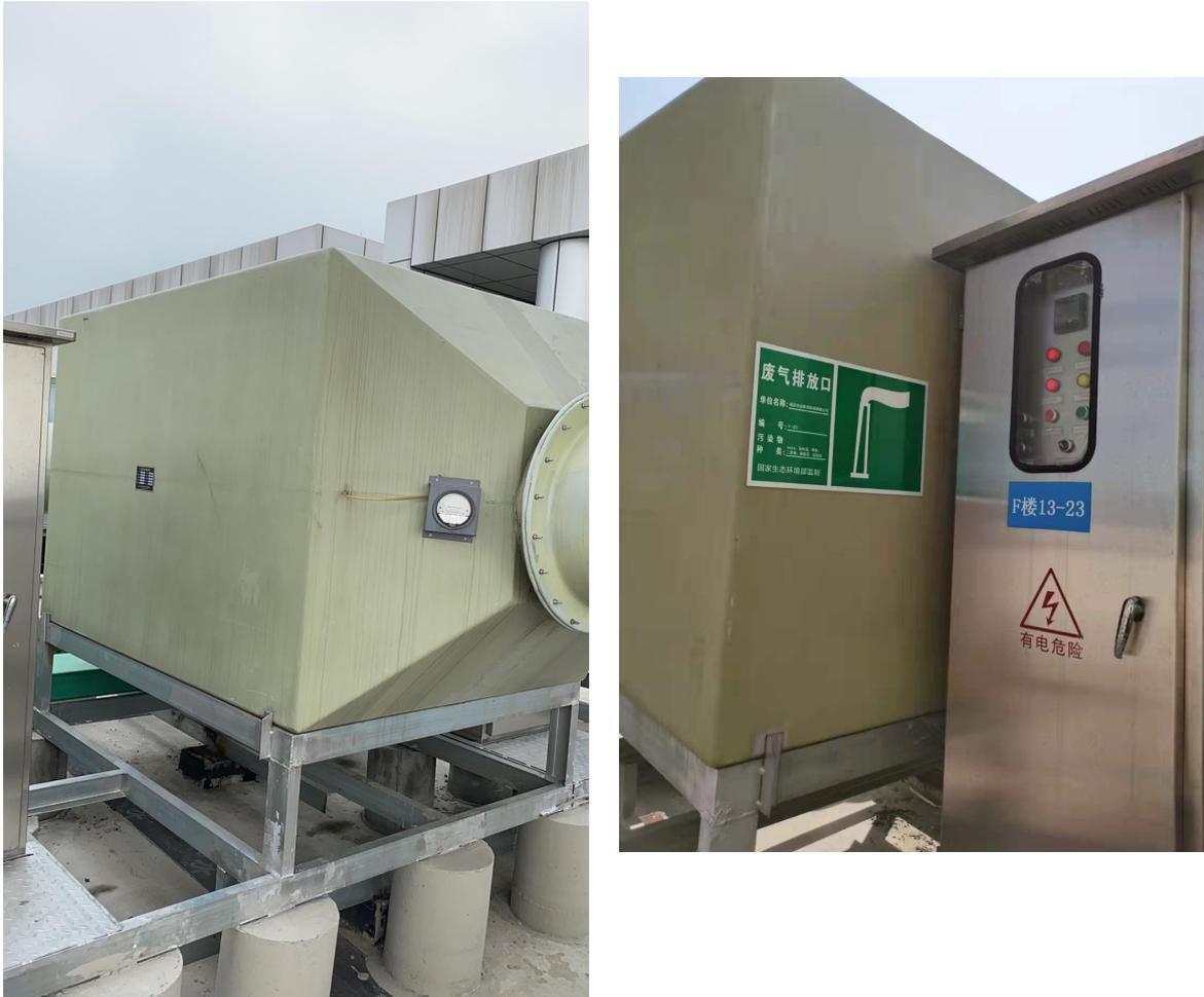
图 3-3 废气处理装置及排口标识
