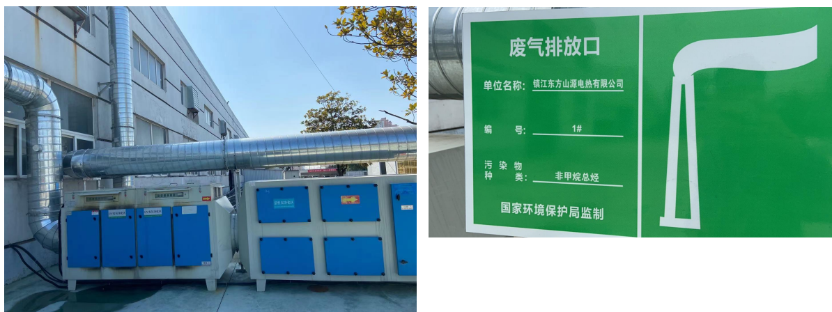
图 4.1-5 废气处理设施
