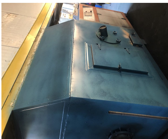
图 4.1-7 水膜除尘装置（3#排气筒）
