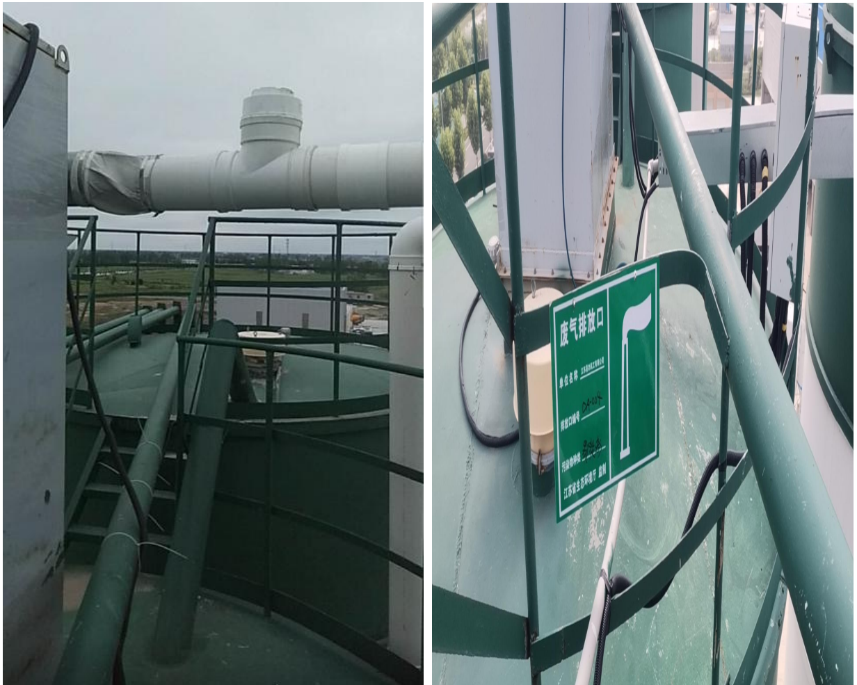
图 4.1-5 废气处理设施（DA004 排气筒）
