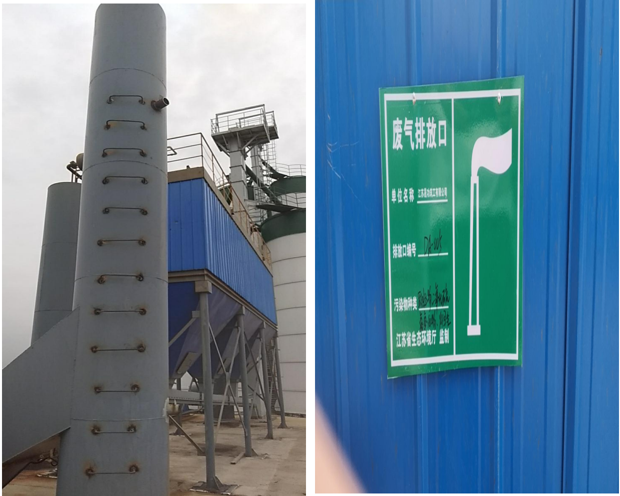
图 4.1-6 废气处理设施（DA005 排气筒）
