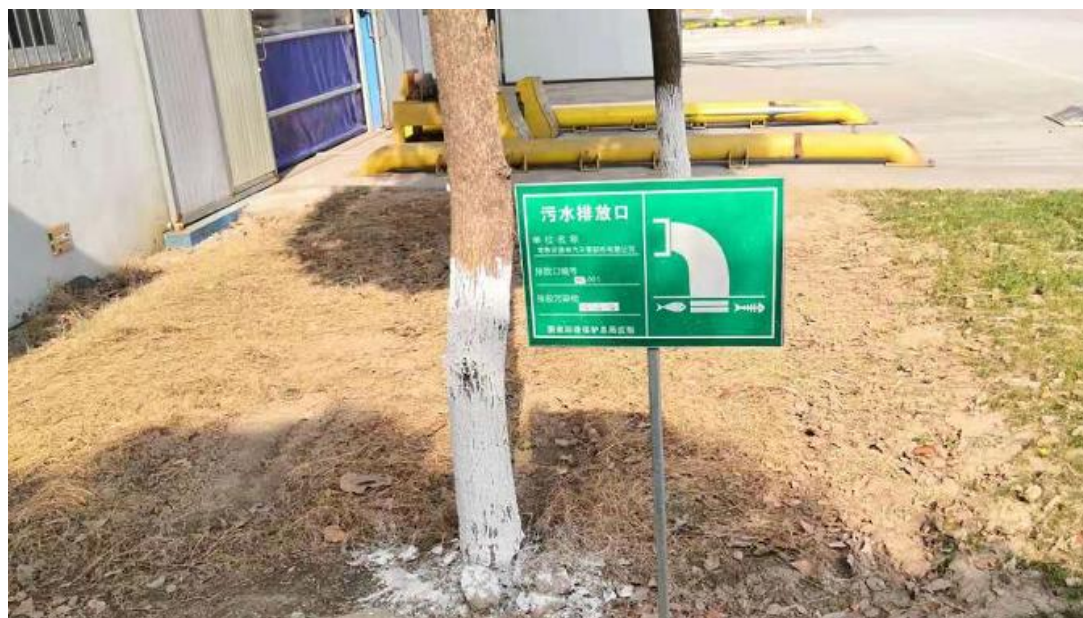
图 3-2 生活污水处理设施及排口
